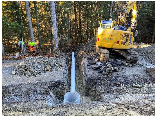
Neubau Durchlass beim Kaminbühl
